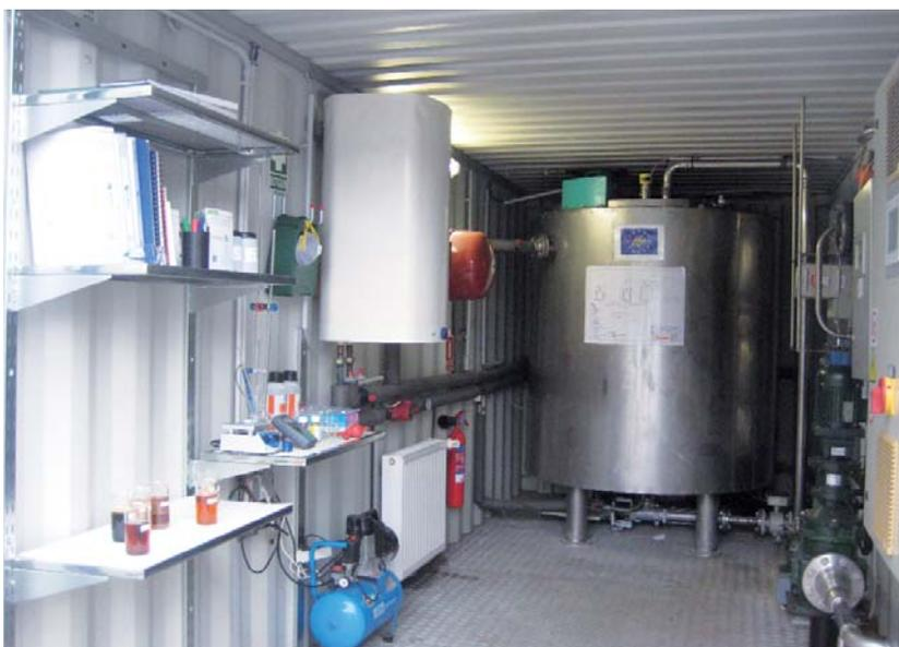
Detalle de parte del módulo de digestión anaerobia
